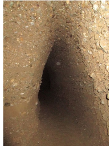
Ravne-tunnelin maanalaiset tunnelit ovat osin holvikaarittyypisiä
